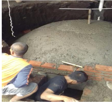
Gambar 10. Pembuatan Reaktor Biogas Type Fixed Dome
